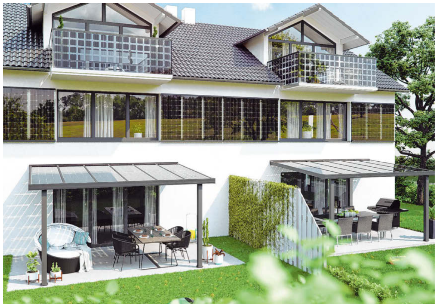
Elegante Optik, umweltfreundlicher Nutzen: Solarelemente in der Fassade und im Terrassendach liefern Ökostrom frei Haus.
